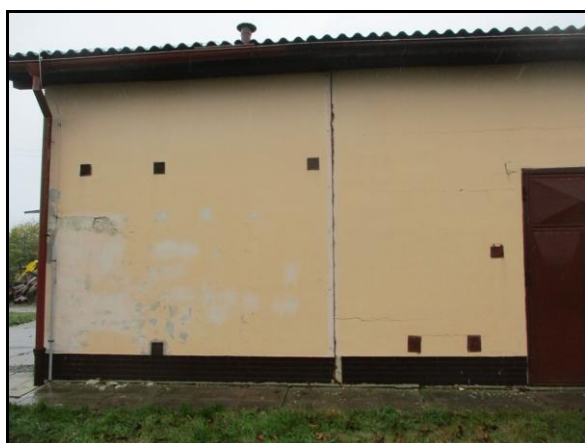
podélné trhliny po celé délce jižní stěny technického domu
