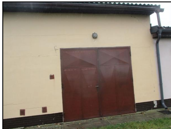
podélné trhliny po celé délce jižní stěny technického domu
